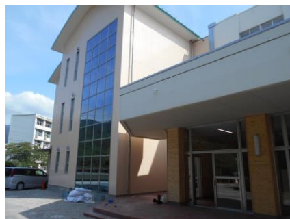
完成したA棟の外観
